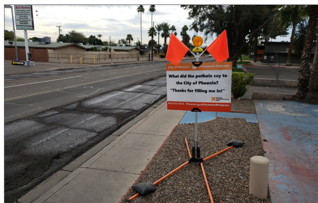
El Departamento de Transporte Vial despacha cuadrillas para rellenar alrededor de 21,600 baches al año.
