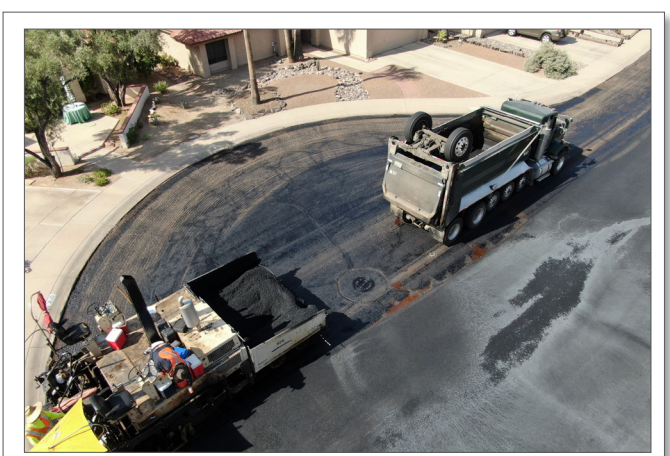
El año pasado, las calles de Phoenix recibieron más de 500,000 toneladas de asfalto, lo que equivale a pavimentar alrededor de 710 canchas de fútbol americano.
